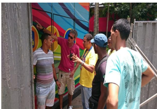
Isolamento de área de acesso para arquibancada
