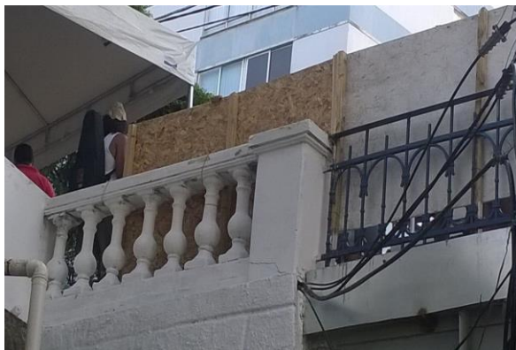
Colocação de tapume no viaduto da Gamboa, para evitar acidentes
