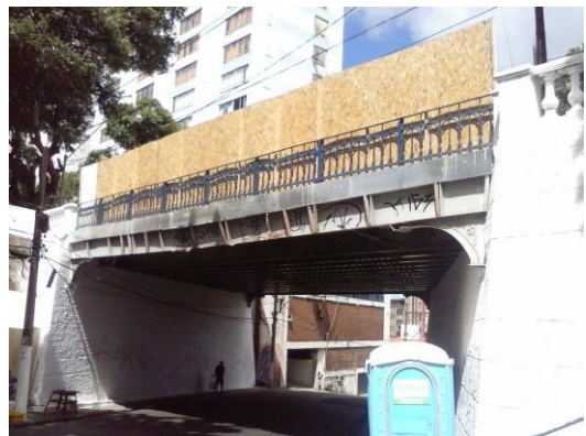
Colocação de tapume no viaduto da Gamboa, para evitar acidentes
