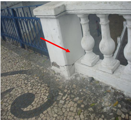
Estruturas em concreto comprometidas
