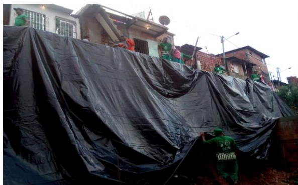
Colocação de lona
